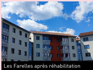
Les Farelles après réhabilitation
