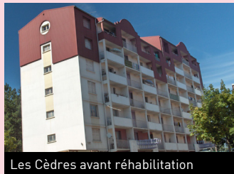
Les Cèdres avant réhabilitation
