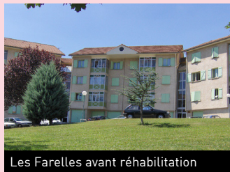
Les Farelles avant réhabilitation
